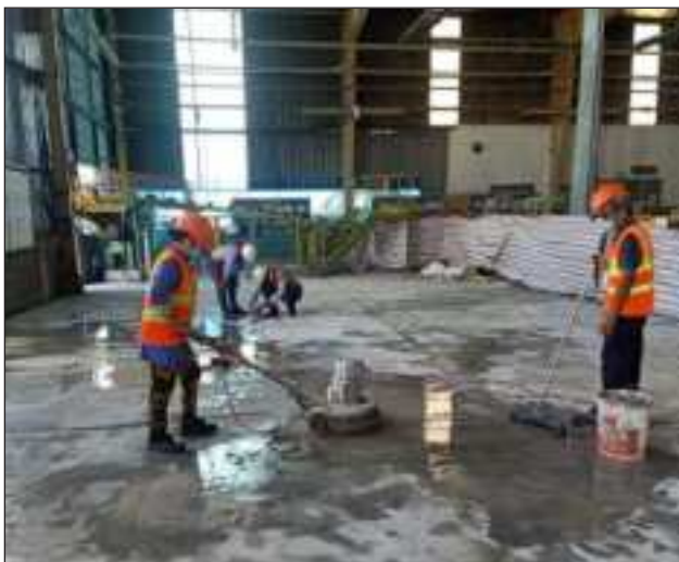
VỆ SINH NỀN BÊ TÔNG CỨ
