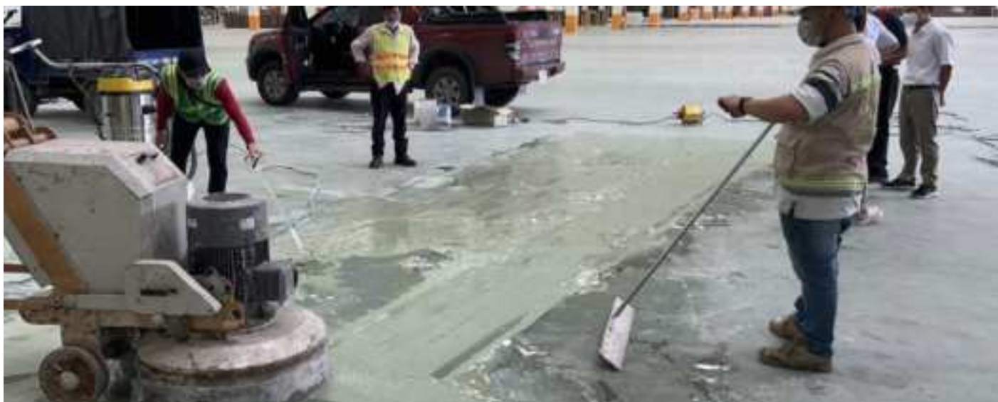
Phối hợp vận hành máy mài và thu gom bụi tại khu vực thi công.
