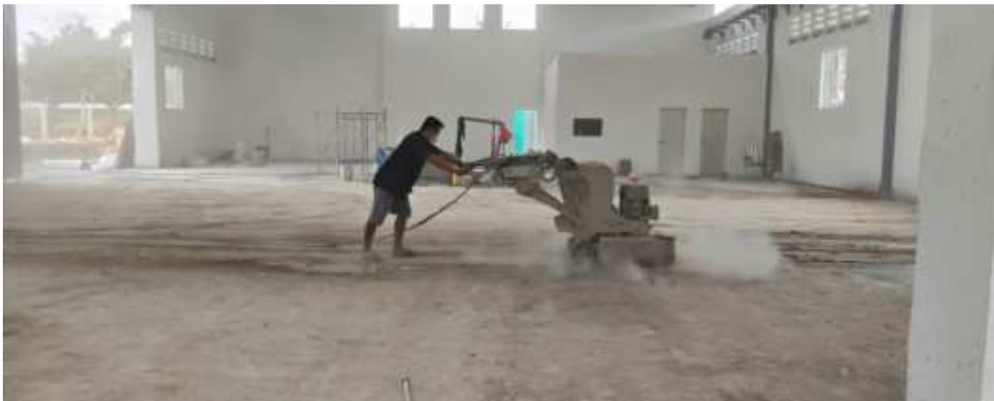
Vận hành máy mài trên mặt bằng nhà xưởng.
