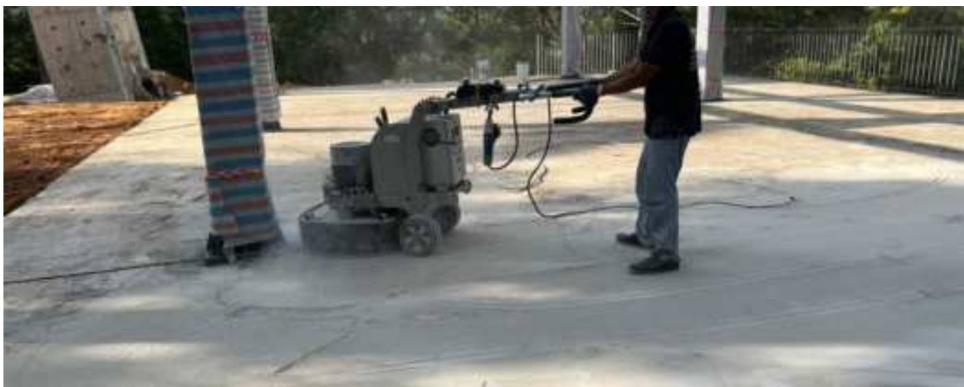
Thi công mài sàn bằng máy lớn tại công trình.
