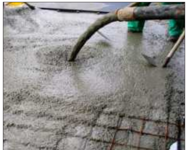
ĐỔ BÊ TÔNG TƯƠI, CẮT NỀN, XOA NỀN
