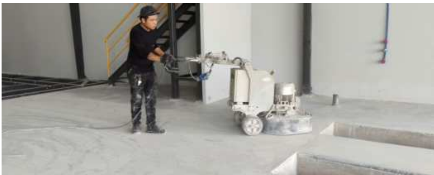
Vận hành máy mài lớn để xử lý bề mặt sàn bê tông.
