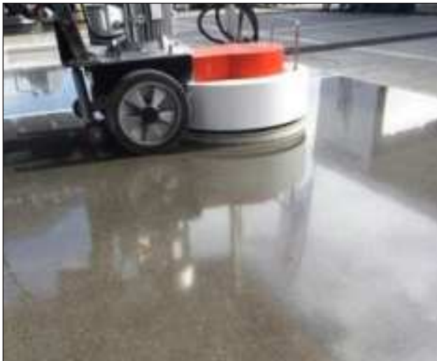
ĐÁNH BÓNG SÀN, ĐÁNH NƯỚC
