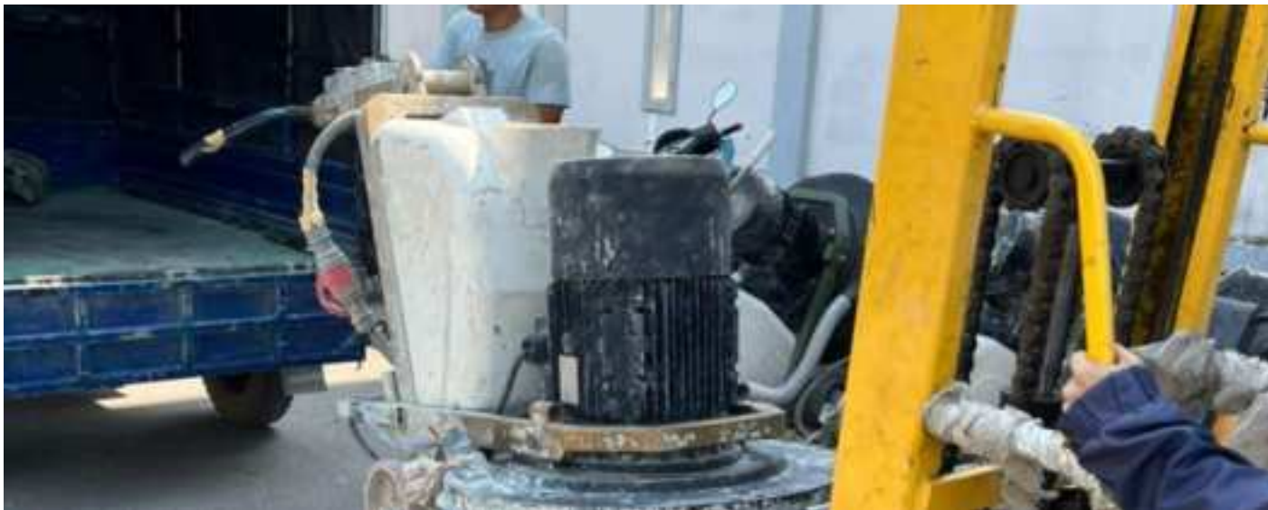
Tập kết và di chuyển máy mài lớn phục vụ thi công.
